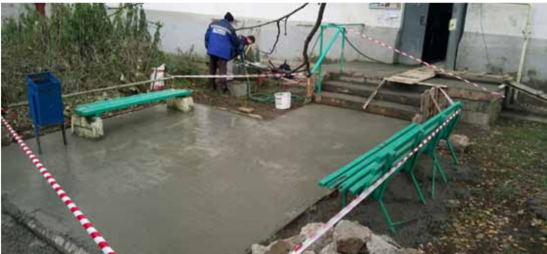
Октябрь 2016 года. Бетонщики УК «Чайковская» на ремонте крыльца и площадки у входа в подъезд, ул. Советская, 11. Фото Антона Сухарева
