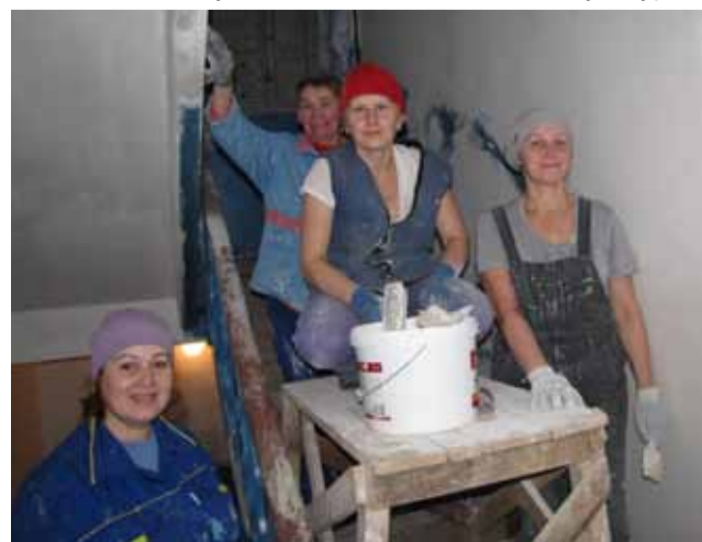
Бригада отделочников приступила к косметическому ремонту в шестом подъезде дома ул. Ленина, 36
